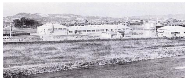
第1期工事の完成した塩原工場 Shiobaru Factory after completion of first stage construction.
