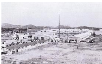
第2期工事の完成した飯塚工場 Iizuka Factory after completion of second stage construction.
